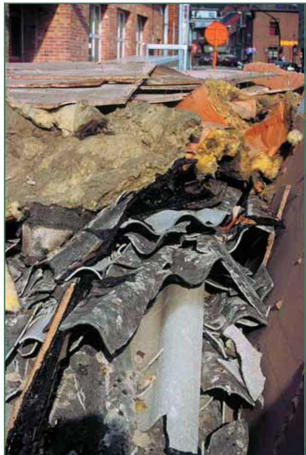
Golfplaten van asbestcement zijn terug te vinden op vele tuinhuisjes. Bron: VIBE
