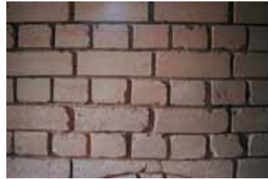
Metselwerk met leemsteen. Bron: VIBE
